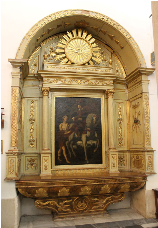
Estado inicial del retablo y el altar previo a la intervención
